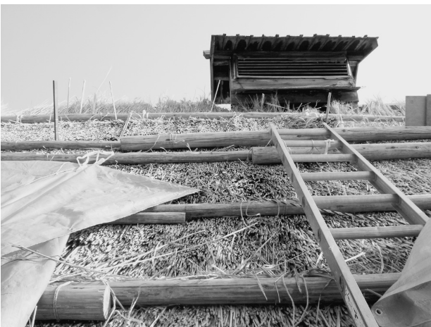
写真-12 旧斉藤家の屋根葺き替え
