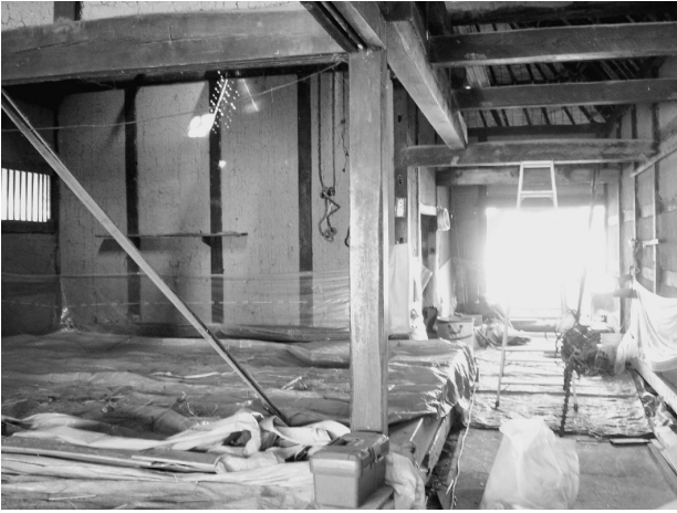
写真-11 旧斉藤家屋内の修理工事
