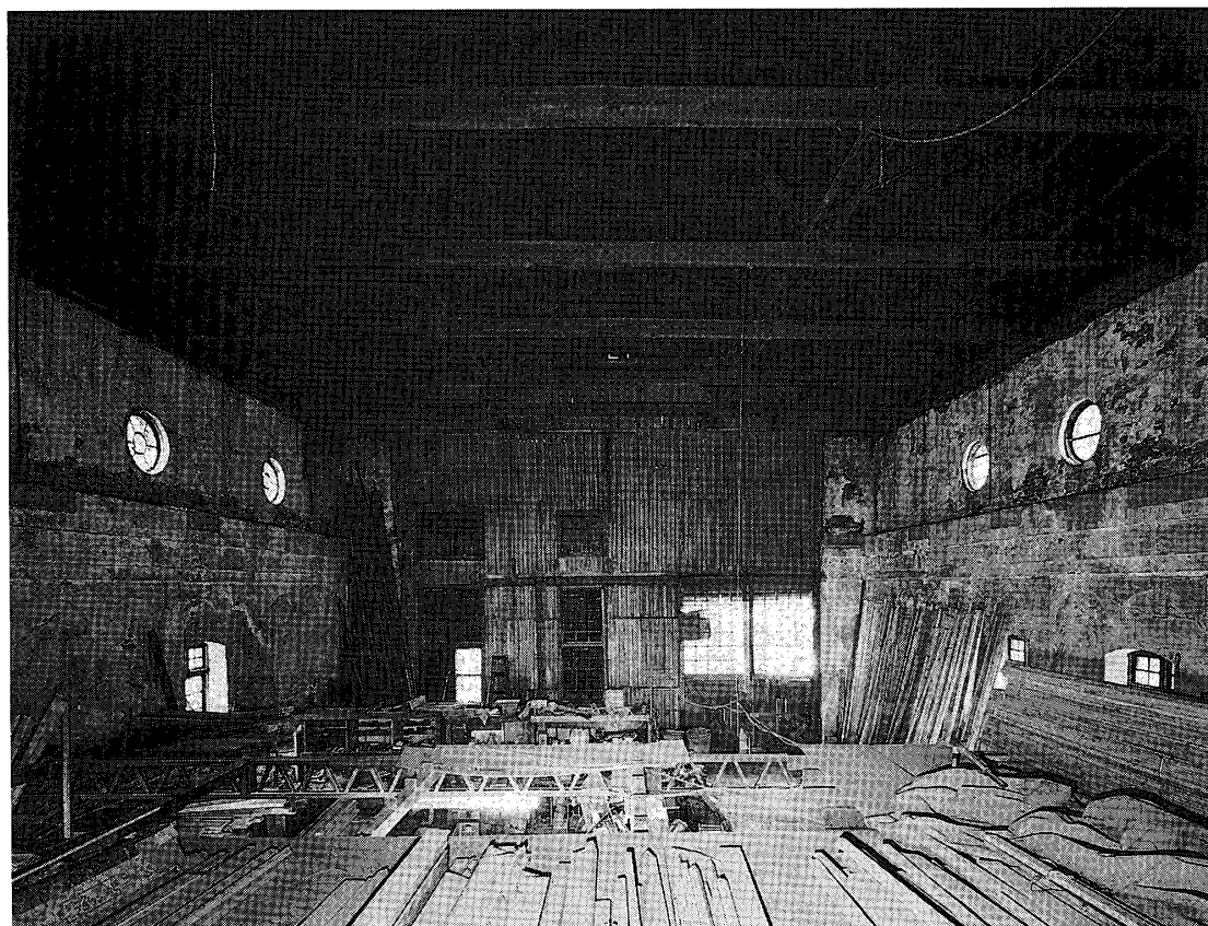
写真-3 室内東方向（出入口）
