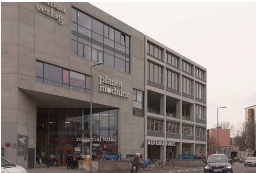
写真 modular の入るビル
