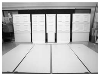
写真19 窓固定済みの壁面パネル
