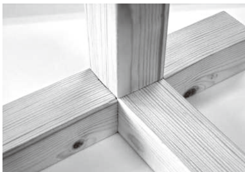
写真12 木造建築の土台と柱脚部分
