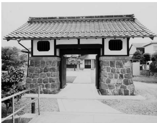
写真5 本目山大雄寺山門外観
