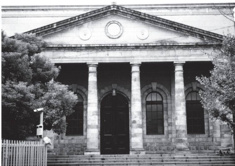
写真—3 旧造幣寮金銀貨幣鑄造所正面玄関
