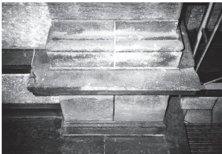
写真—2 修理工事中の旧日本郵船小樽支店
