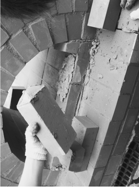
写真一7 煉瓦端部の小口にモルタルをのせる
