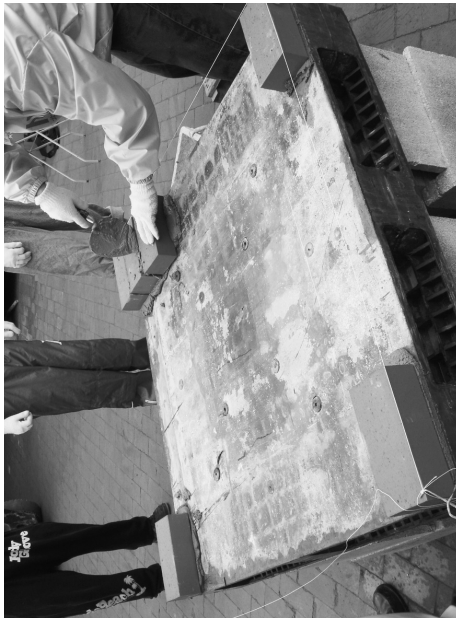
写真-1 基準に水糸を張って窯を積み始める
