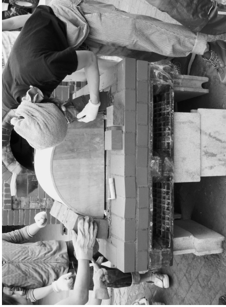
写真-3 木製櫛形を使いアーチを積み上げる
