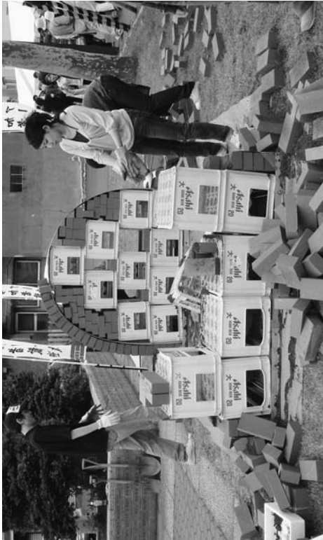
写真一 3 昨年度のアーチ積で最初の失敗事例
